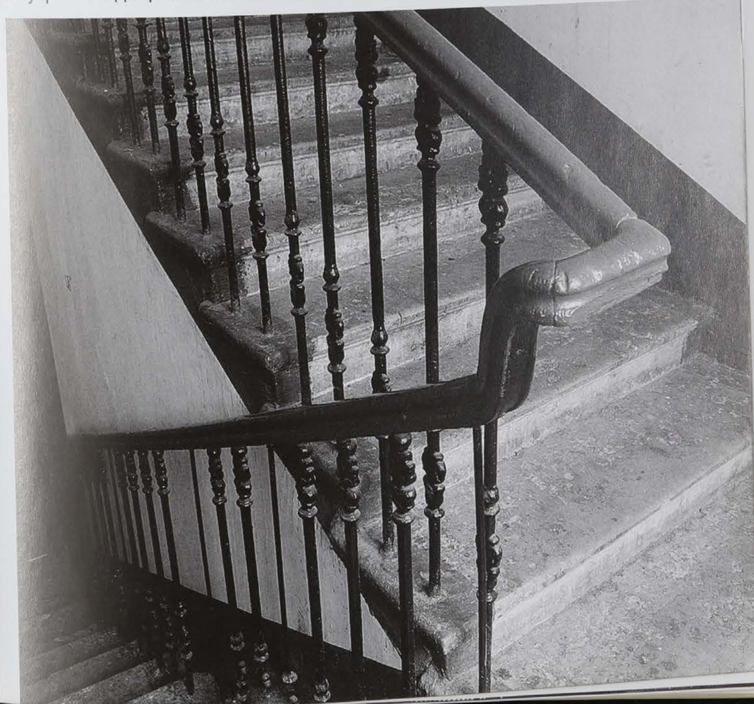
Внутренний двор и лестница в доме 25 по 10-й линии Васильевского острова.
